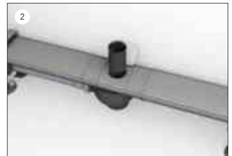
Dichtigkeitsprüfung durch den Installateur: In die Öffnung des Rohbauschlutzes wird das Tauchrohr eingesetzt...
